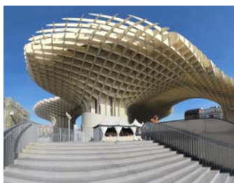
Metropol Parasol Největší dřevěná konstrukce na světě
