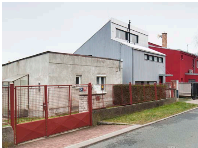
3/ Příklad dřevěného rodinného domu v městské zástavbě – dům Babu, Archport. Foto: archiv Archport
