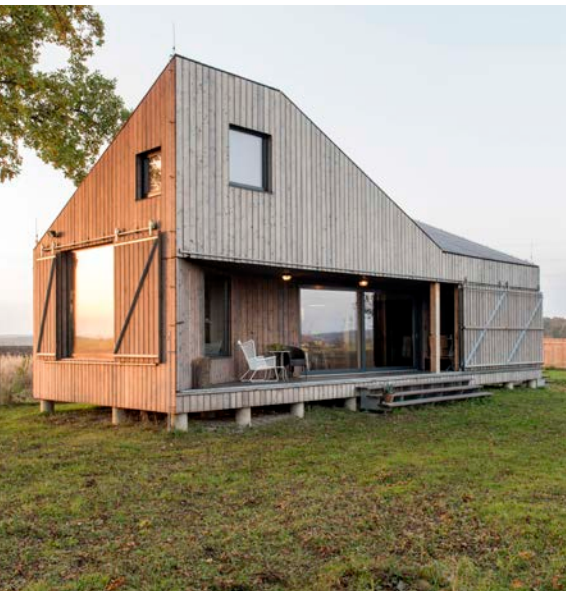
1/ Prototyp dřevěného nízkoenergetického rodinného domu – dům Zilvar, ASGK Design. Foto: Petra Hajská
